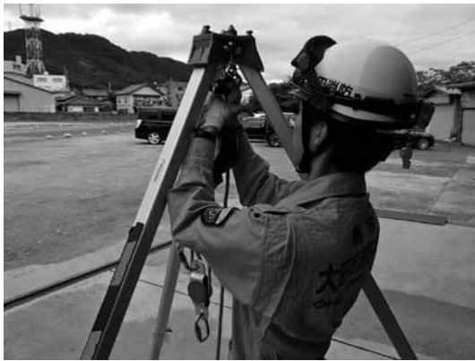
写真5 ロールグリスの取付け
