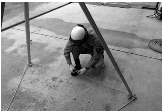
写真6 三脚の確保ロープを設定
