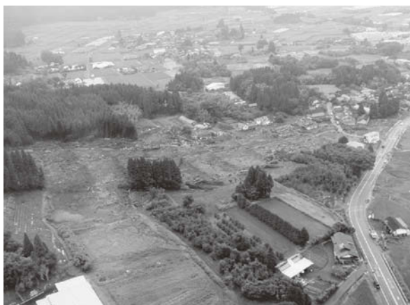
土石流が発生した現場（提供／熊本県防災消防航空隊）
