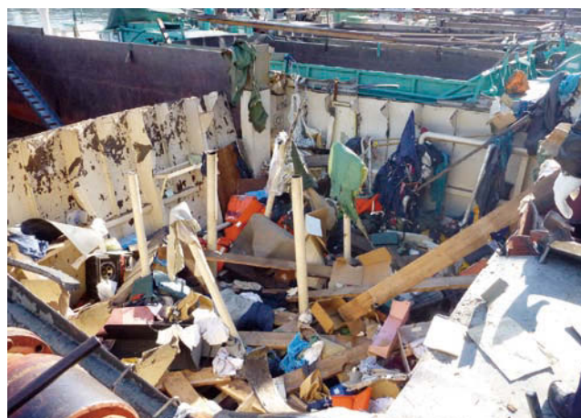
船室内の状況
