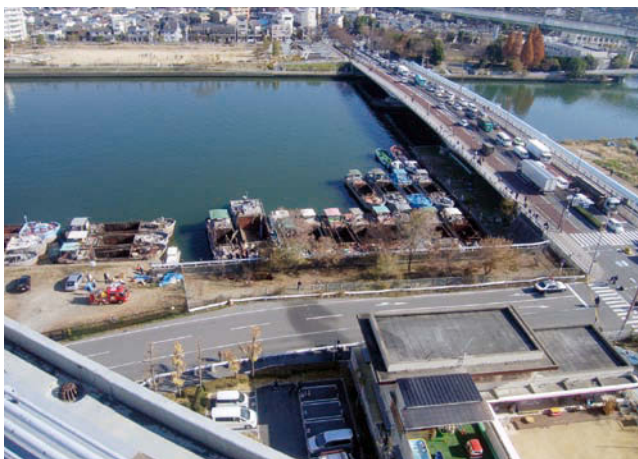
現場付近の状況
