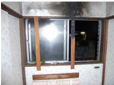
写真7 洗面化粧台が設置されていた腰高窓
