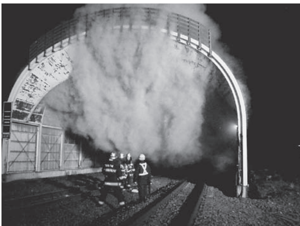
写真1 煙を吐き出す第1ニウトンネル。 (新夕張側から撮影)
